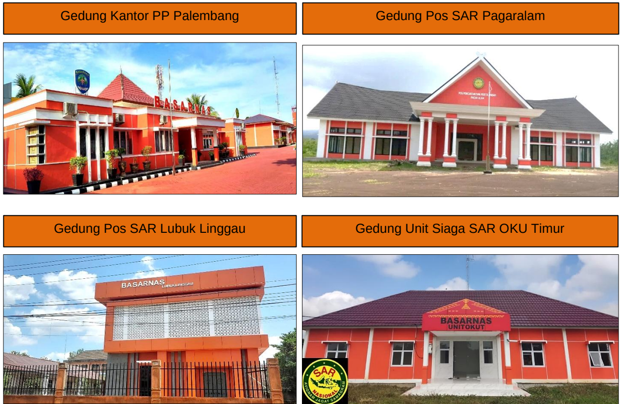
Gambar 1.8 Gedung Prasarana yang dimiliki Kantor Pencarian dan Pertolongan Palembang
